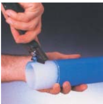
Fig. 29 3. Deklaag met handschaaf volledig verwijderen. Niet over de markering!
