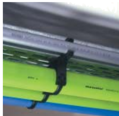
Fig. 70: RAUPEX onder of naast KDS geïnstalleerd.
