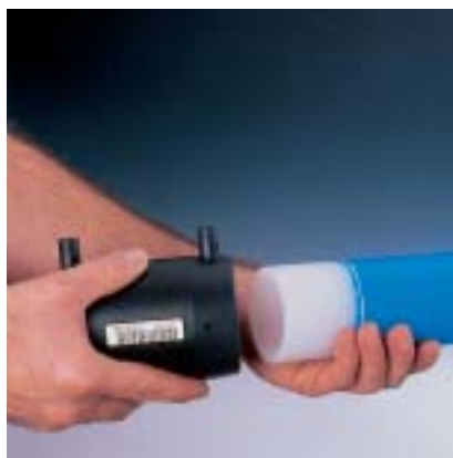
Fig. 33 7. Elektrolasmof op het ene buiseinde schuiven.
