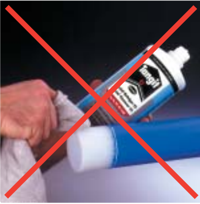
Fig. 62 Geen gebruikte lappen gebruiken voor het schoonmaken. Alleen waterbestendige, nieuwe celstofdoeken gebruiken.
