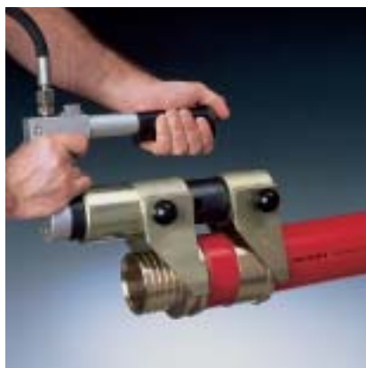
Fig. 21 7. Gereedschap op de verbinding plaatsen. Niet schuin houden.
