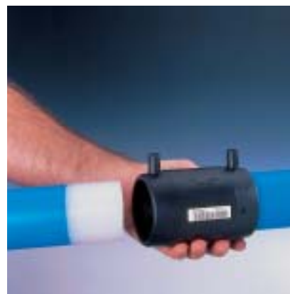
Fig. 34 8. Tweede buiseinde in de mof schuiven. Het afgeschraapte gebied moet geheel in de mof verdwijnen.
