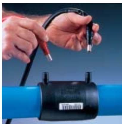
Fig. 39 13. Er klinkt een geluidssignaal na afloop van de lasprocedure. De stekkers kunnen worden losgemaakt.
