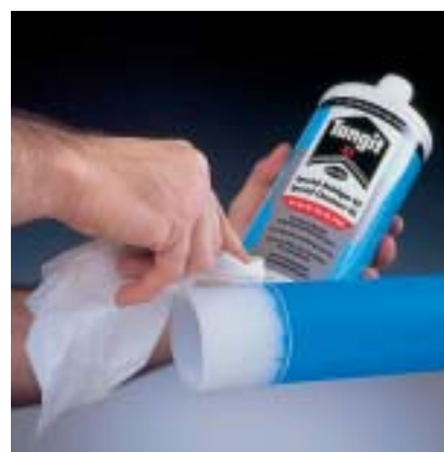
Fig. 31 5. De laszone moet vet- en stofvrij zijn, indien nodig met Tangit-reinigingsmiddel schoonmaken.
