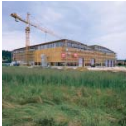
Fig. 87: Productiehal in houtskeletbouw.
