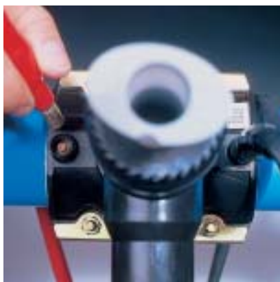
Fig. 44 5. Lasapparaat aansluiten; de rode kabel op het rode contact.
