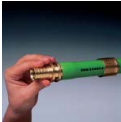
Fig. 11 5. Fitting in de buis steken. Na korte tijd zit de fitting vast in de buis.
