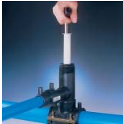
Fig. 49 10. Na doorboren van de buis de gatenboor linksom tot de aanslag terugschroeven.
