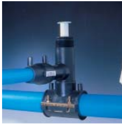
Fig. 47 8. Na 20 minuten afkoeltijd de buis op de aftakking aansluiten. Dan het gehele circuit aan de aftakking aan een drukbeproeving onderwerpen.
