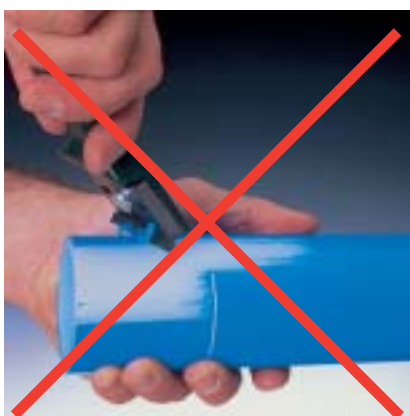
Fig. 56 Niet over de markering afschrappen!
