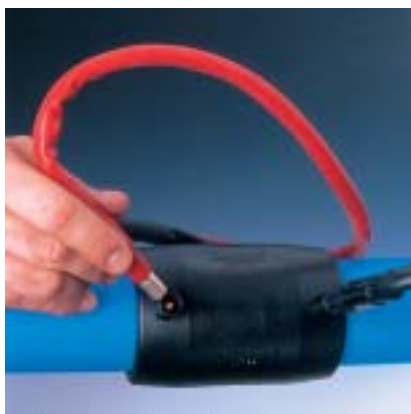
Fig. 35 9. Lasapparaat aansluiten; de rode kabel op het rode contact.
