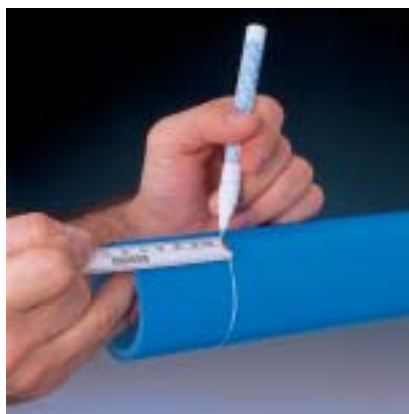
Fig. 28 2. De afschraapmaat conform tabel 5 aftekenen.
